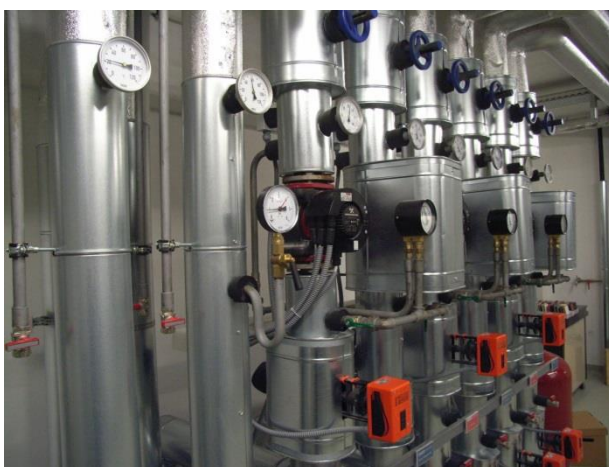
Wärme-/Kälte-Hauptverteilung
