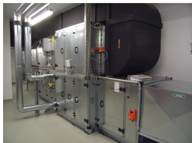
Lüftungs-Zentralgerät
