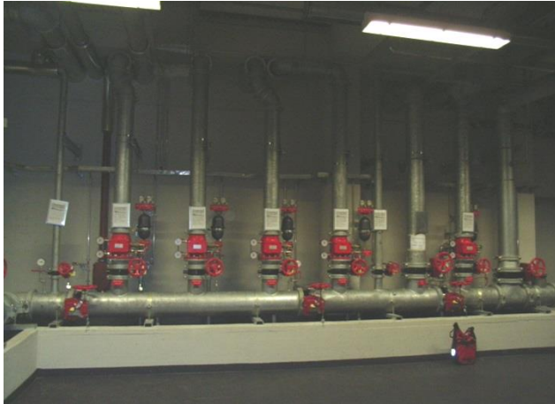
Sprinklerhauptverteilung
