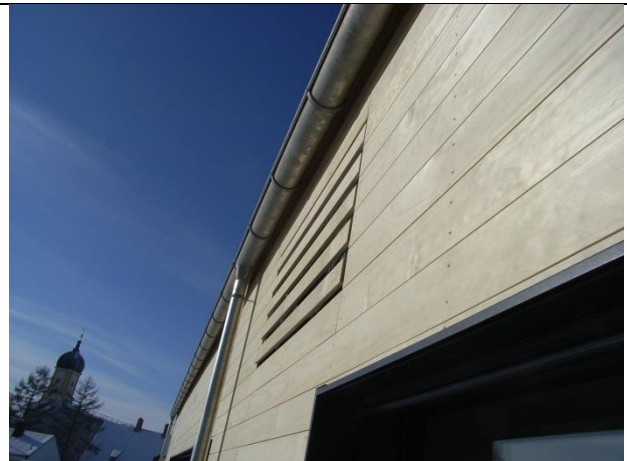
fassadenintegrierte Außenluftansaugung
