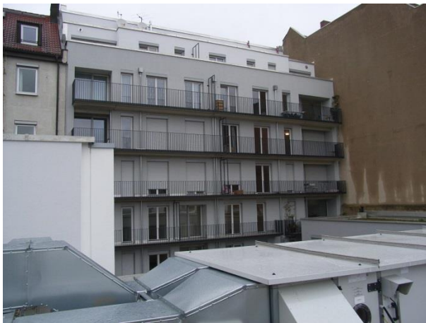
Südfassade VGB Neubau mit Lüftungsgerät RGB Neubau
