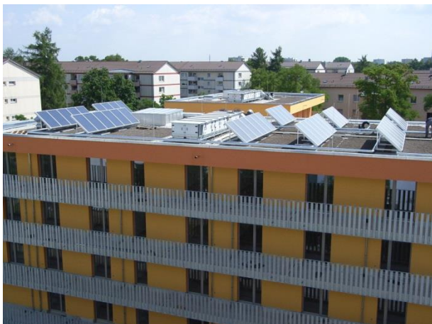
Westfassade mit Dachaufsicht Lüftungsgeräte/ Solar
