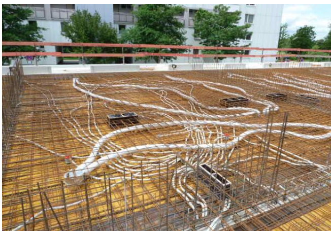
Lüftungsinstallation innerhalb der Betondecke
