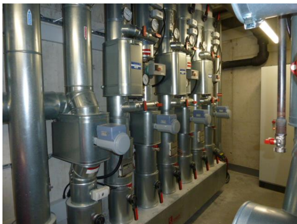
Heizungsverteiler Technikzentrale
